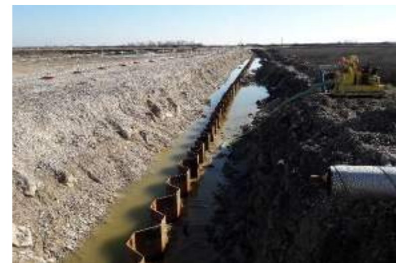
Foto di cantiere interventi airside – 2019
