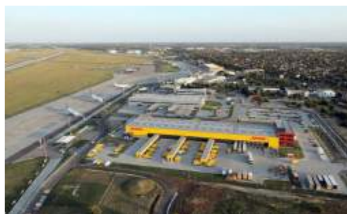
Esempio di magazzino Cargo con baie di carico Tir
